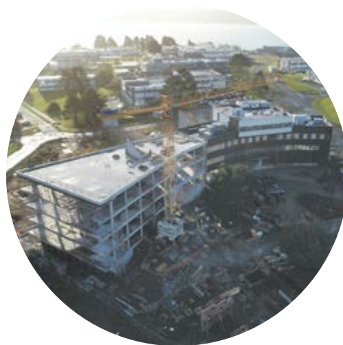
VUE AÉRIENNE DU NOUVEAU BÂTIMENT EN CONSTRUCTION, AU SIÈGE DE L'IFREMER EN BRETAGNE © Ifremer - S. Lesbats
